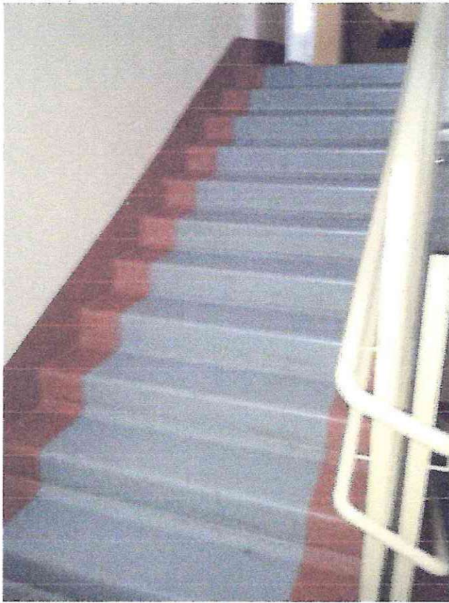
Фото № 9. Лестница (внутри здания)
