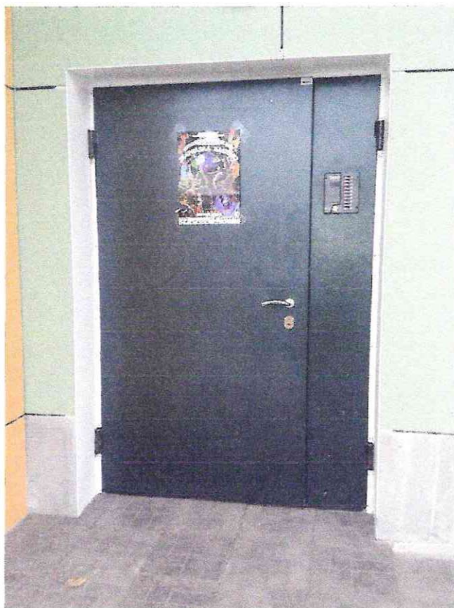
Фото №5. Дверь (входная).
