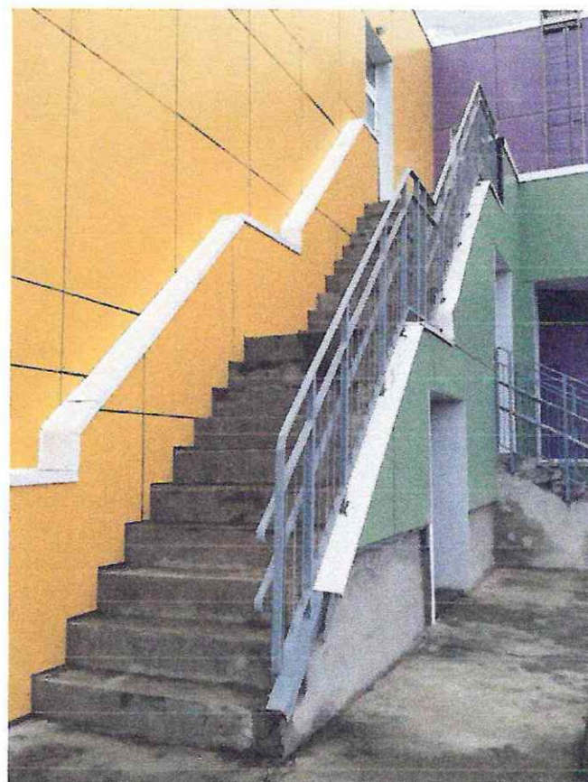
Фото №12. Пути эвакуации.
