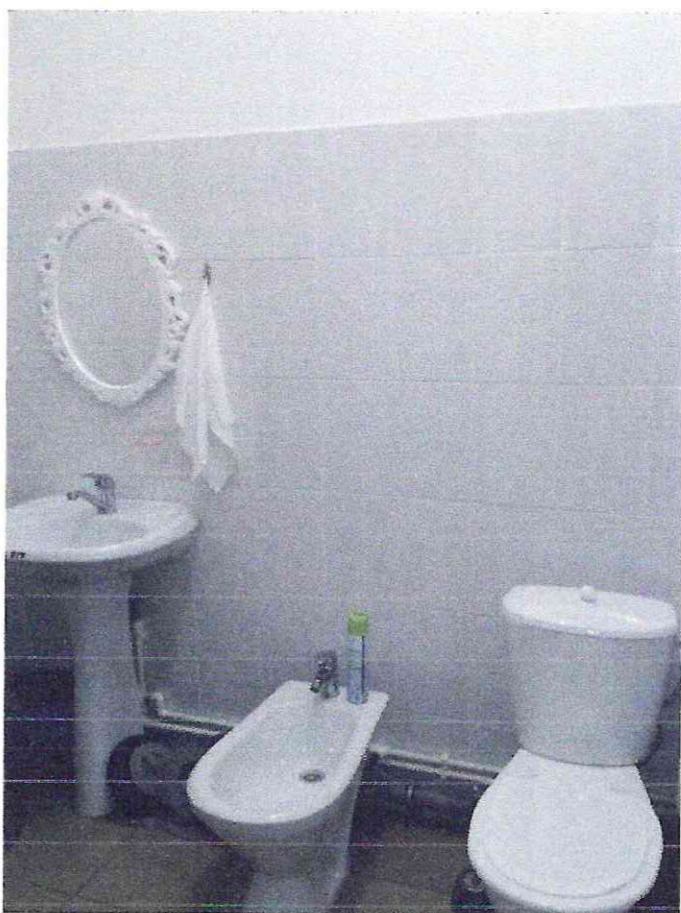
Фото №17. Туалетная Комната.
